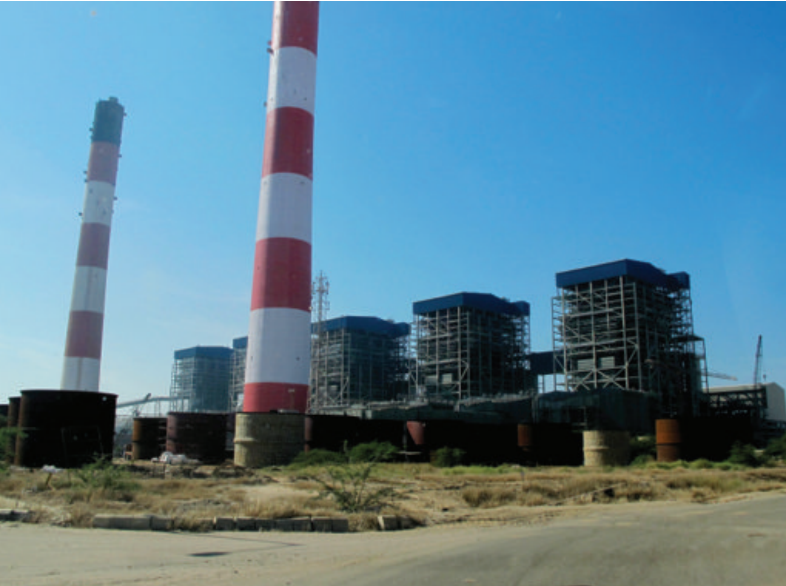
La usina de energía térmica de Tata CGPL, de 4000 Megavatios, bajo construcción.
